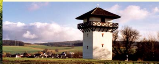
Der rekonstruierte Limesturm bei Dasbach
